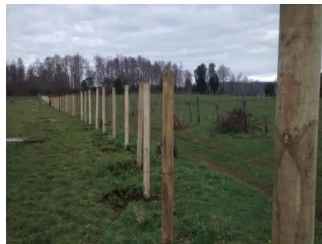
Construcción de Cercos
