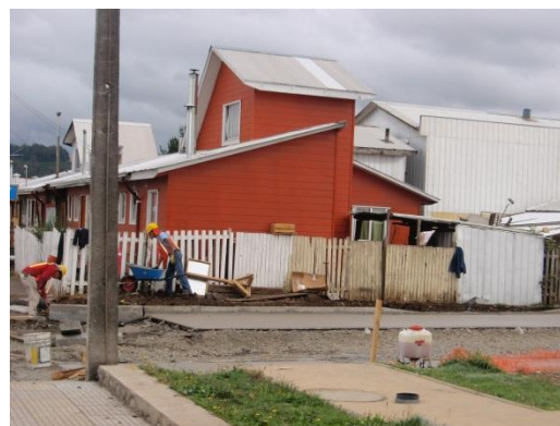
Pavimentación calle Corretue
