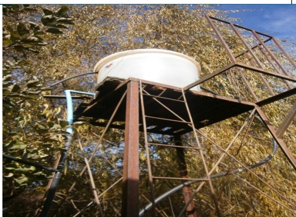
MEJORAMIENTO CAPTACION AGUA ESCUELA LEFUCO
