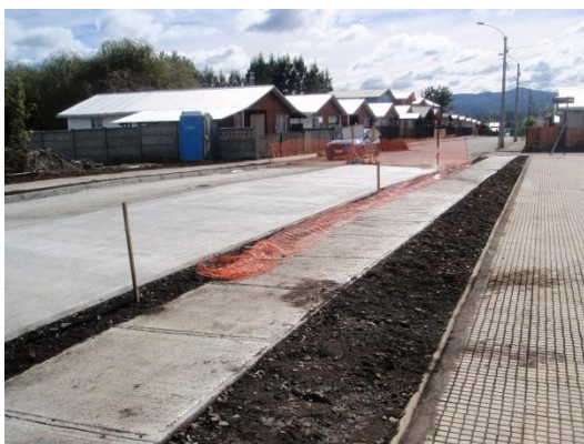
Pavimentación calle 21 de Mayo
