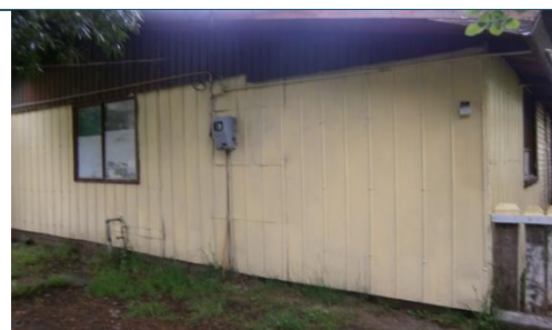
REPARACION COCINA SAN ARTURO
