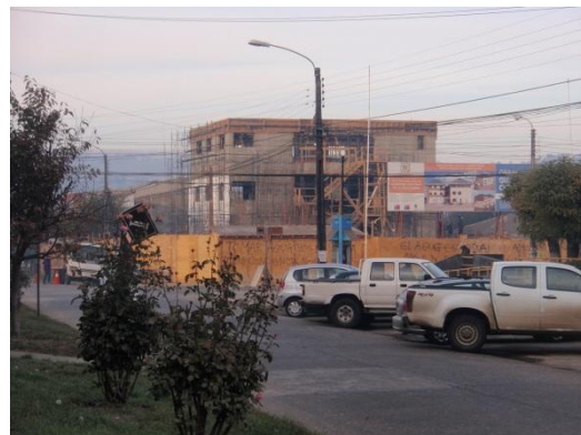
Obra en ejecución
