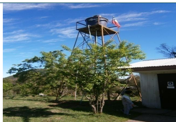
REPARACION CAPTACION AGUA Y BAÑOS ESCUELA COLLICO
