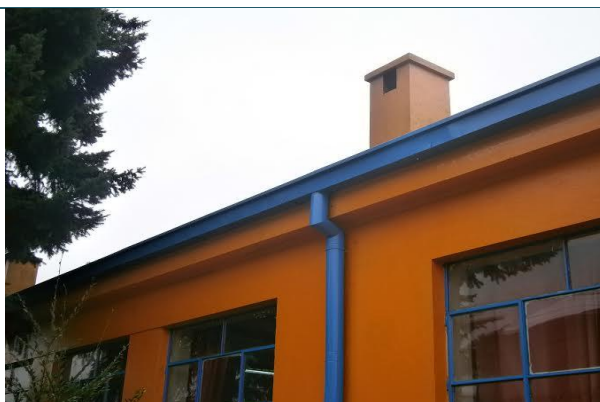
PINTURA FACHADA LICEO LAS ARAUCARIAS
