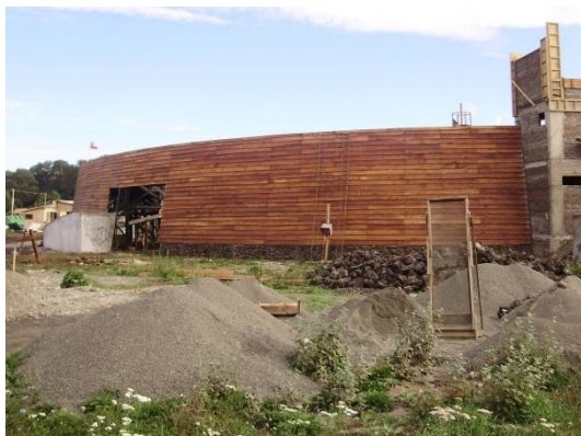
Construcción Media Luna Municipal
