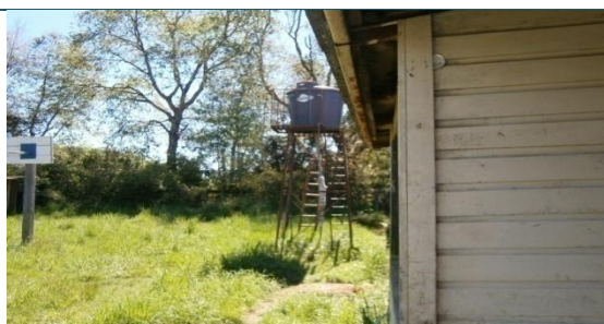
REPARACION CAPTACION AGUA ESCUELA RADALCO
