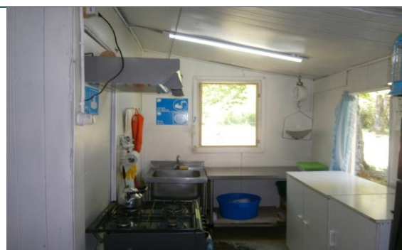
REPARACION COCINA ESCUELA RADALCO
