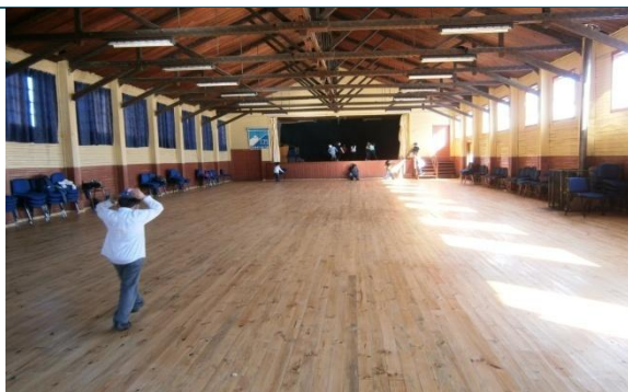
CAMBIO PISO Y VITRIFICADO SALON ACTOS LICEO SECCION BASICA
