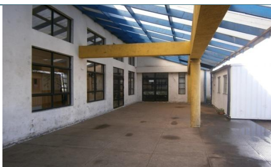
REPARACION TECHO PATIO EXTERIOR ESCUELA PATRICIO CHAVEZ
